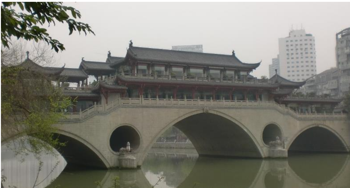
図 7 安順廊橋（東・上流側）
