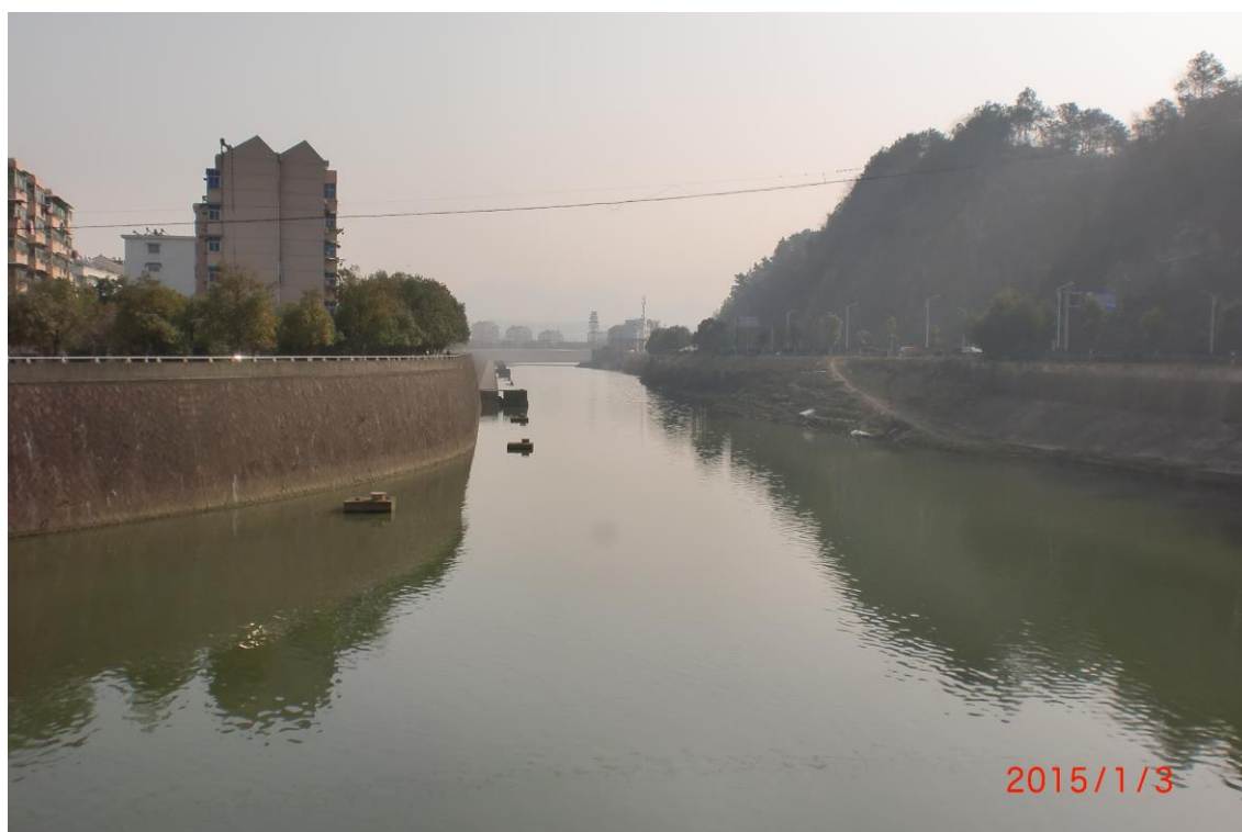
図6 旧城址(左)の南城壁沿いに流れる南門溪、奥で常山江に合流する
