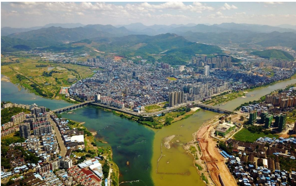
图3 現建瓯鳥観図（左水西橋、右水南橋）
