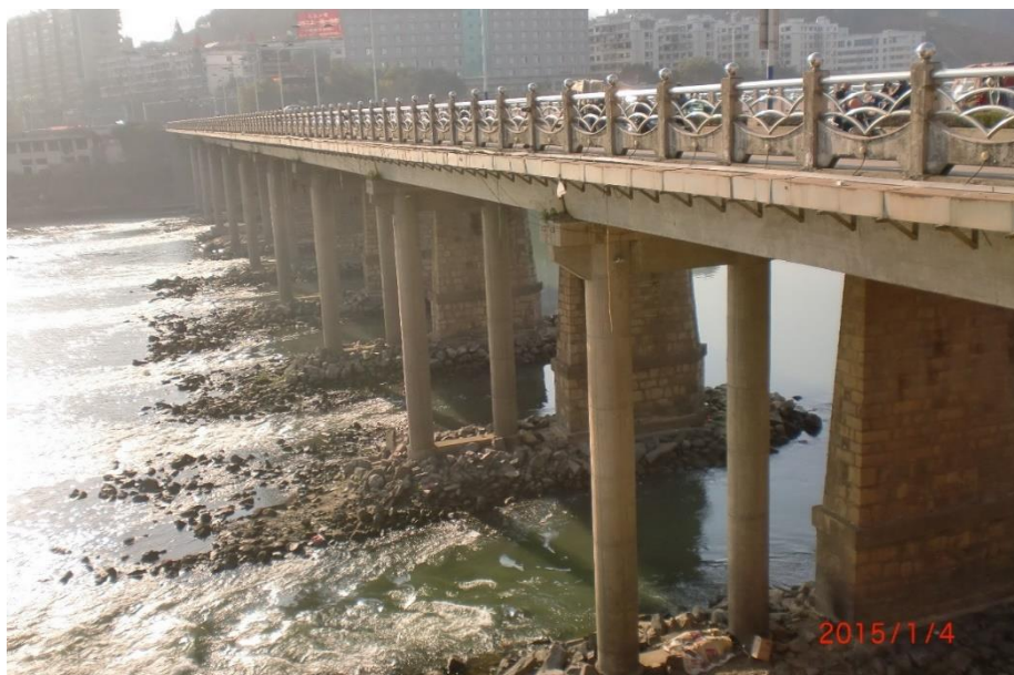
図8 水西橋（下流側、手前は近代に拡幅された部分）
