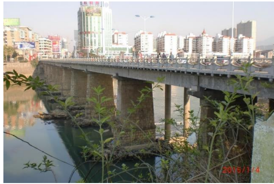
図1 水西大橋（上流側）橋脚の下に残る昔の基台
