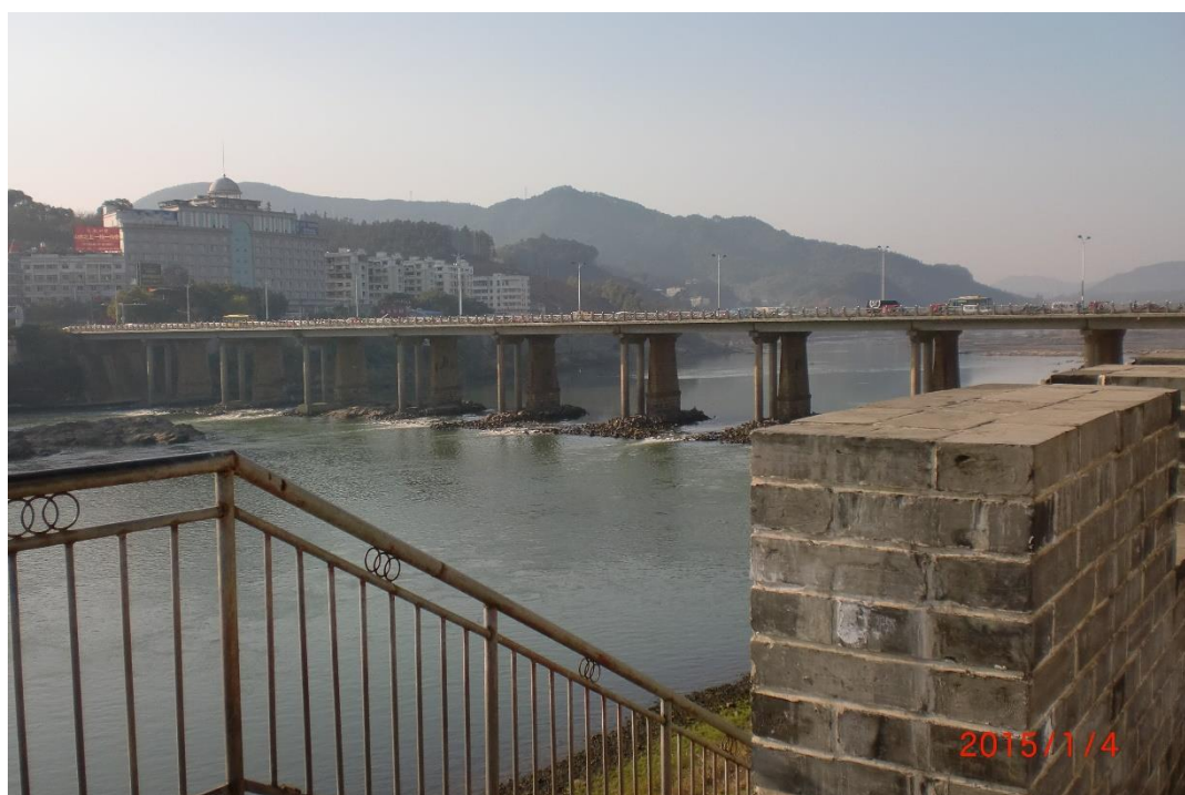
図 11 建溪と水西橋（下流側）
